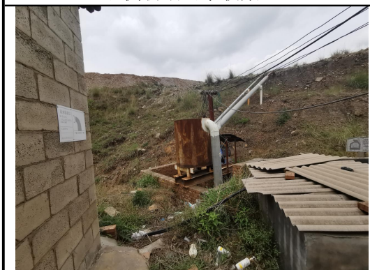
初期雨水收集池及生活污水沉淀池
