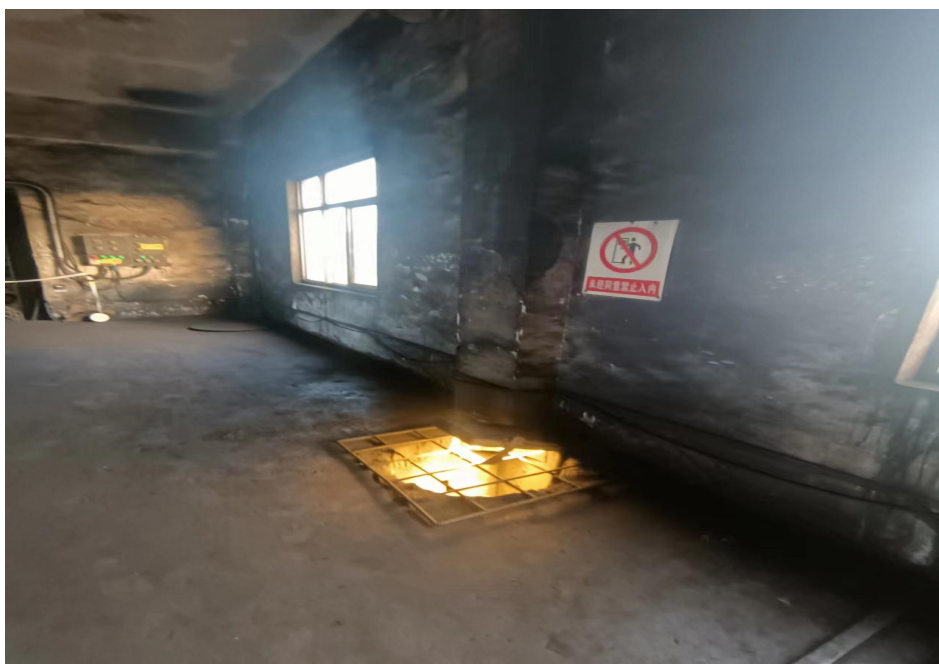
图二 煤塔顶部人孔
