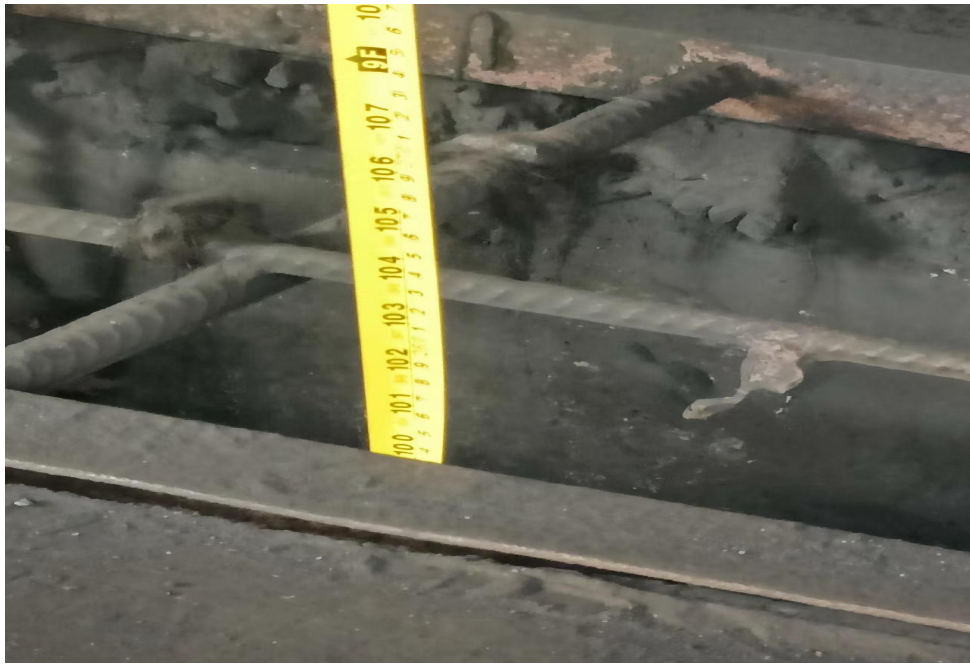
图四 事故调查时煤塔内部煤表面至仓口距离
