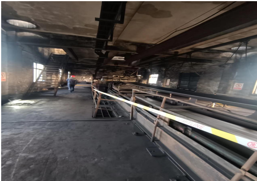
图一 炼焦车间煤塔顶部平台
