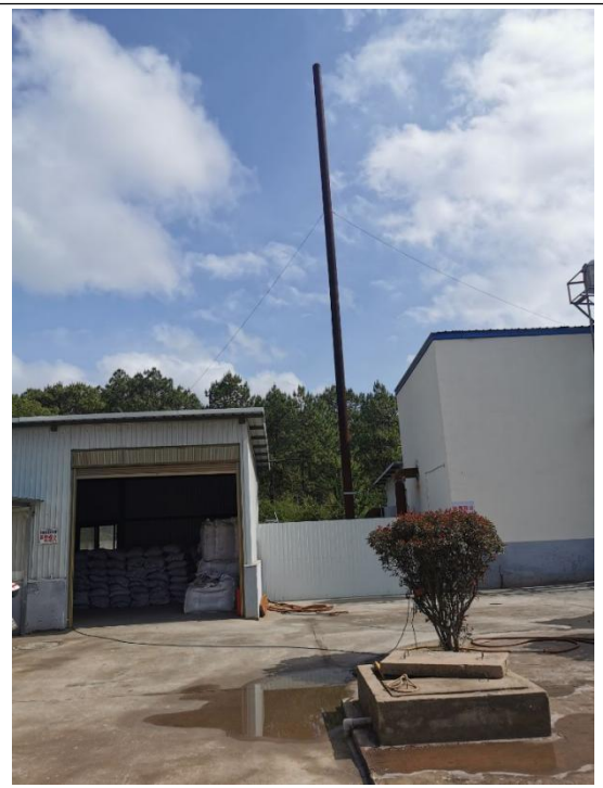
现有项目锅炉房燃料库及排气筒
