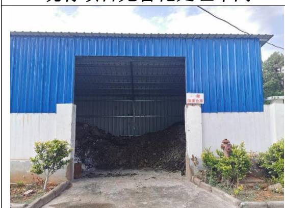
现有项目一般固废仓库
