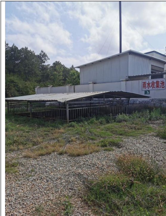
已建初期雨水收集池
