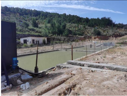
1#雨水收集池（原项目初期雨水池）
