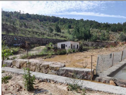
原项目检修工具房
