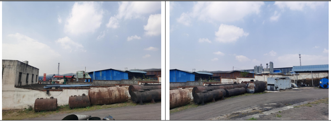
废旧沥青储罐未及时清理
