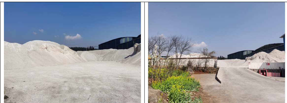
项目内砂料堆放区现状
